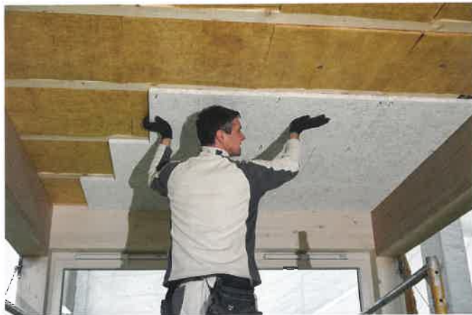
Bild 4. Die Holzwolleplatten von Fibrolith wurden bereits in der Montagehalle an die Decken der einzelnen Module montiert
