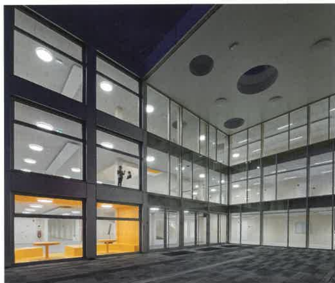
Bild 5. Für eine helle und freundliche Atmosphäre wurden in den den Fluren und der dreigeschossigen Eingangshalle sowie in den Klassenräumen weiße Holzwolleplatten eingesetzt
