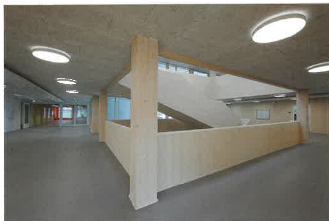
Bild 7. Auch im Treppenhaus und Foyer kamen Holzwolleplatten zum Einsatz
