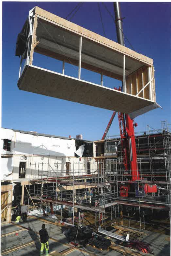
Bild 3. Die Schule im Bau
