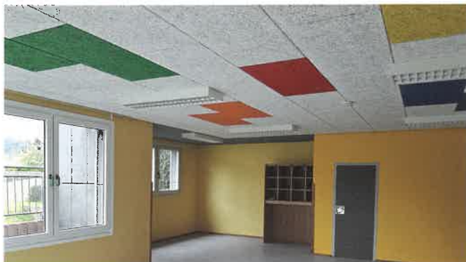
Bild 1. Mehrzweckraum des katholischen Kindergartens in Kempenich (Eifel): neue kunterbunte Akustikdecke in den RAL-Farben der fünf Kindergartengruppen
