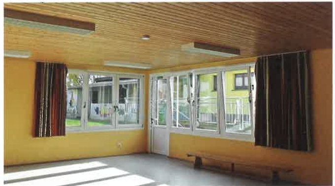
Bild 2. Die alte Holzdecke war maßgeblich für die schlechte Raumakustik im Kindergartenraum verantwortlich
