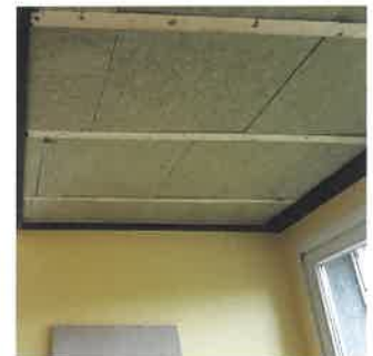
Bild 3. Die mit Mineralwolle gefüllten Zwischenräume der vorhandenen Holz-Unterkonstruktion dienen als zusätzliche Schalldämmung
