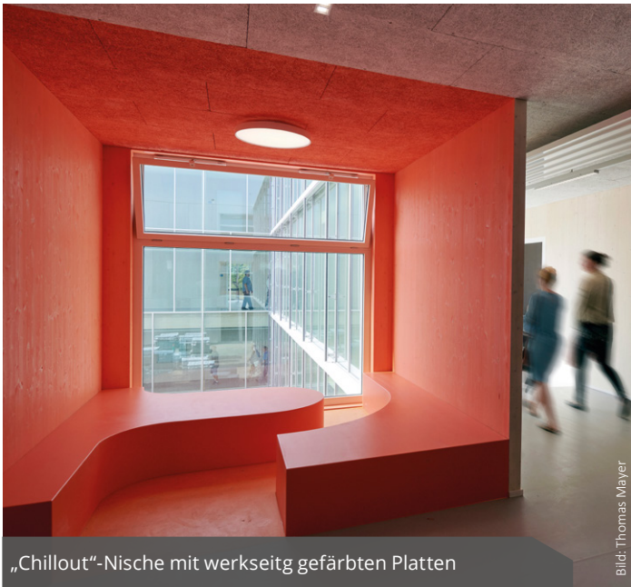
Holzwoleplatten schlucken den Schall im Klassenraum
