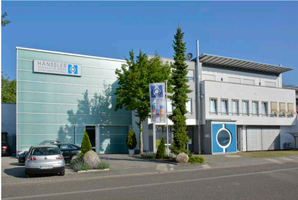
Büro- und Fertigungsgebäude der Firma Hänsler Hydraulik GmbH in MA-Friedrichsfeld
